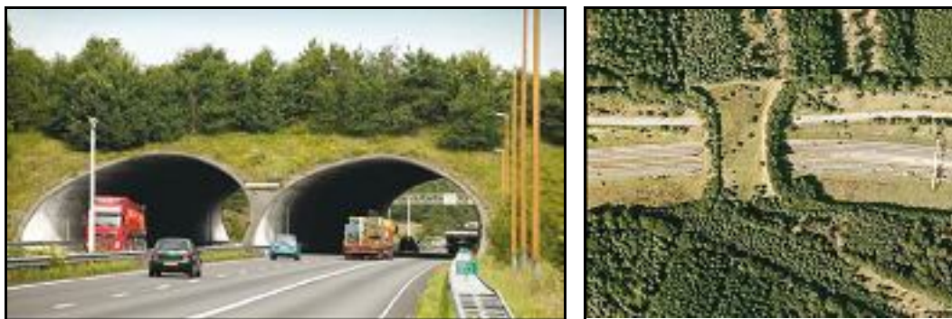
Рис. 4. Пример экологического «зеленого» моста, соединяющего лесные и парковые экосистемы, разделенные дорогами, для создания непрерывности сети зеленых зон и сохранения биоразнообразия на урбанизированных территориях (экодукт в Голландии)
